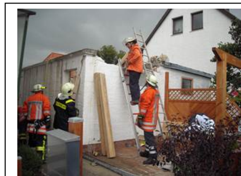
Abstützung der Garagenrückwand
