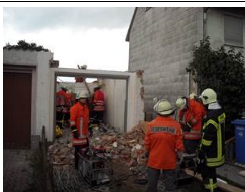
Die Einsatzstelle, Gerät wird bereit gestellt
