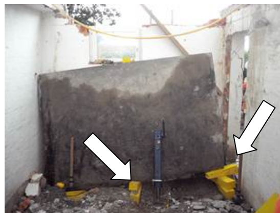
herabgestürzte Stahlbetondecke
